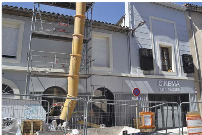
La façade du cinéma en cours de rénovation.
